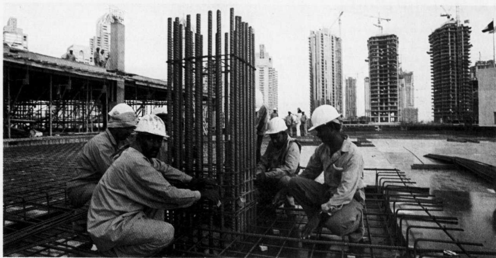
Un chantier de construction à Dubaï, dans les Émirats arabes unis.
