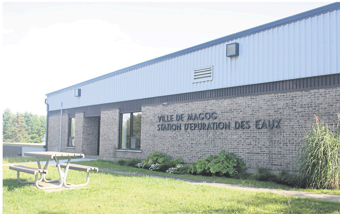
L'usine d'épuration des eaux de la rue de Hatley serait rajeunie et sa capacité de traitement serait accrue, si la Ville de Magog allait de l'avant avec le projet qu'elle a élaboré. — PHOTO LA TRIBUNE, JEAN-FRANÇOIS GAGNON
