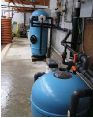
Filtre à sable et filtre biologique avec argile expansée et unité de recherche avec petits bassins à fond conique
