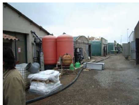
Échangeurs de chaleur pour conditionner la température de l'eau et de l'unité de filtration biologique situé à l'extérieur pour la partie de la production consistant le démarrage larvaire
