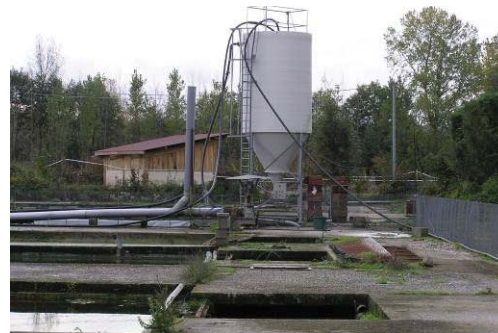
Vue d'un filtre à tambour à la sortie de la deuxième section de la station piscicole (engraissement) et vue du silo servant aux essais sur la concentration et la stabilisation des boues piscicoles
