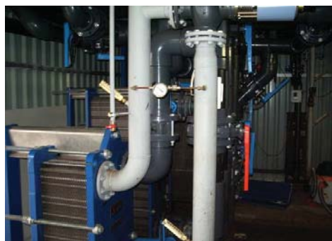
Échangeurs de chaleur pour conditionner la température de l'eau et de l'unité de filtration biologique situé à l'extérieur pour la partie de la production consistant le démarrage larvaire
