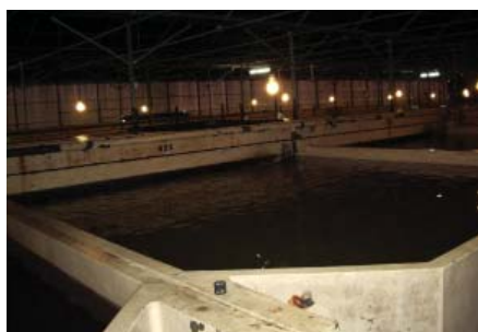
Vue des bassins d'engraissement de forme carrée à coins chanfreinés et une vue des cônes de sursaturation d'eau en oxygène
