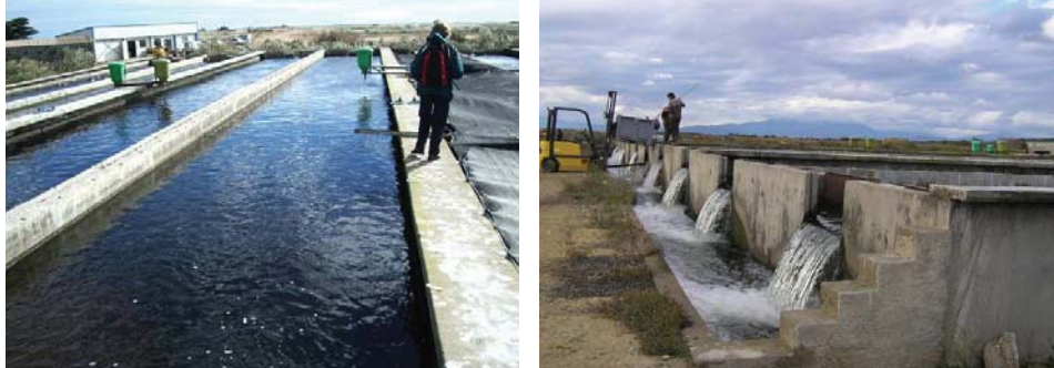
Bassins de type « raceway » pour l'engraissement du loup (en circuit ouvert)
