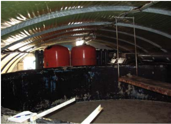
Bassins circulaires pour les individus de 1 à 50 g, unités de biofiltration à l'arrière et grilles pour les équipements de calibrage des poissons
