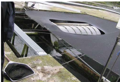
Vue d'un filtre à tambour à la sortie de la deuxième section de la station piscicole (engraissement) et vue du silo servant aux essais sur la concentration et la stabilisation des boues piscicoles
