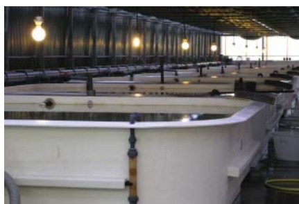
Vue des bassins pour le démarrage des juvéniles et unité de traitement d'eau de ces mêmes unités (filtre à tambour et filtre biologique)
