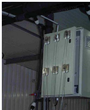
Système de pompes doseuses pour l'alimentation avec des rotifères et nourrisseur à courroie pour l'aliment artificiel
