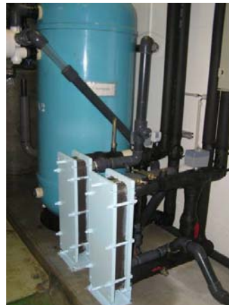
Bouilloire de chauffage d'eau et échangeur de chaleur permettant d'ajuster la température désirée dans une section de recherche
