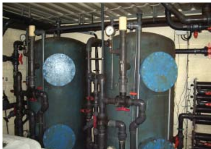
Cylindres de biofiltration avec des argiles expansées et unité de traitement d'eau adaptée à un besoin particulier et utilisant aussi des granules d'argiles expansées
