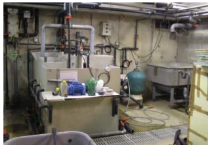
Cylindres de biofiltration avec des argiles expansées et unité de traitement d'eau adaptée à un besoin particulier et utilisant aussi des granules d'argiles expansées
