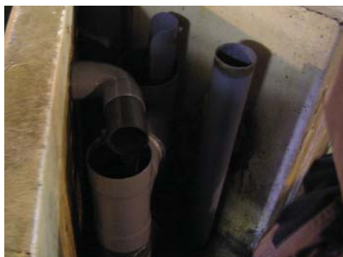
Sorties des bassins à doubles drains soit un au centre au fond et un autre en périphérie et images illustrant la densité d'élevage des turbots
