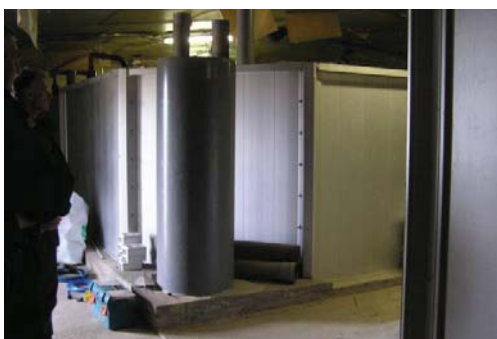
Bassin de 50 m 3 en acier avec membrane et crépine et drain au centre
