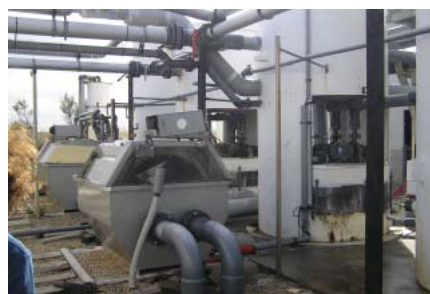
Vue des bassins pour le démarrage des juvéniles et unité de traitement d'eau de ces mêmes unités (filtre à tambour et filtre biologique)
