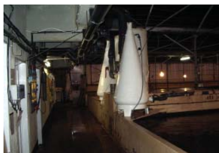
Vue des bassins d'engraissement de forme carrée à coins chanfreinés et une vue des cônes de sursaturation d'eau en oxygène
