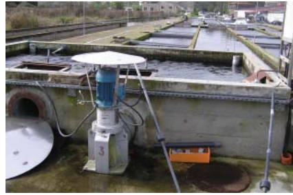
Source d'eau et unité de dégazage par pression négative
