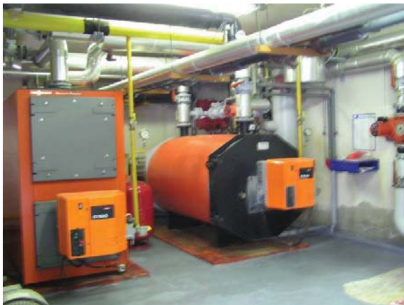
Bouilloire de chauffage d'eau et échangeur de chaleur permettant d'ajuster la température désirée dans une section de recherche
