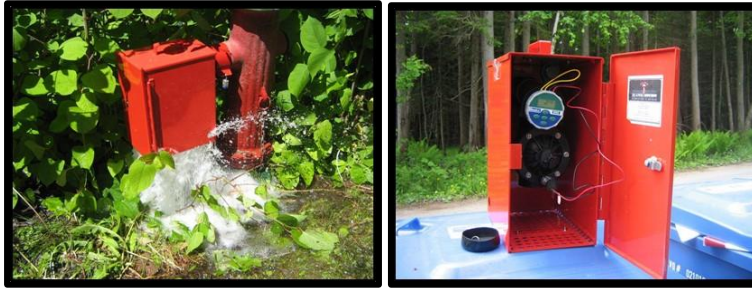
Figure 24. Purges programmables sur poteau d'incendie
