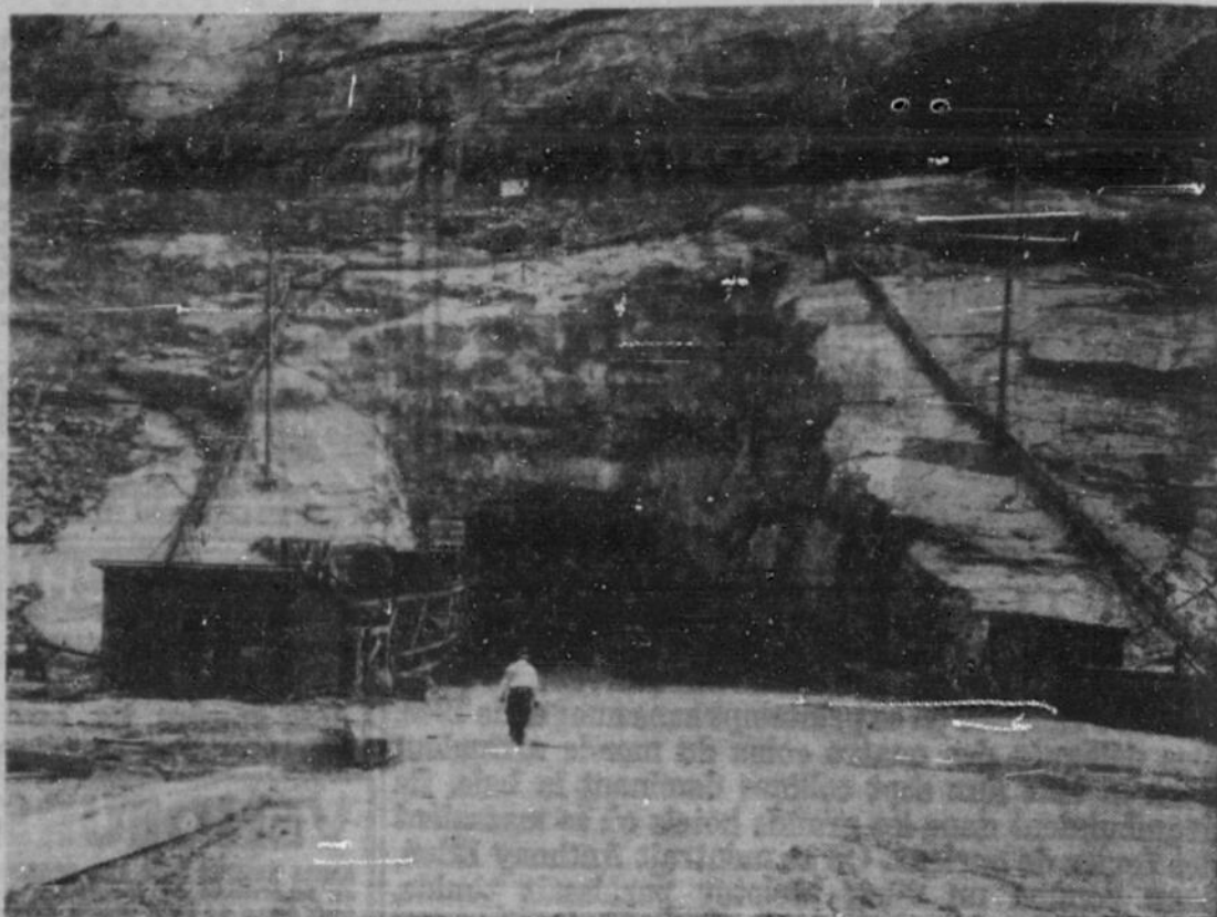
L'ENTREE BEANTE DE LA CENTRALE DE LABRIEVILLE. — Au terme du tunnel de 7 milles et demi, l'eau fera actionner les turbines de cette colossale centrale souterraine, la seule du genre dans le Québec. Il n'existe qu'une seule autre centrale de ce type au pays, celle de Kitimat, en Colombie canadienne. Le cheval électrique installé de Bersimis coûtera à l'Hydro moins de $130. On pourra le transporter vers Montréal. Même si son transport coûte de $65 à $70, on l'aura à meilleur marché que celui qu'on obtiendrait de Lachine dans les conditions les plus favorables qu'on puisse imaginer, ou de tout autre aménagement près de Montréal. (Photo Marcel Deschamps)
