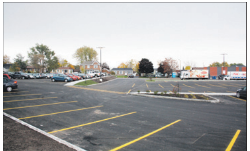
Déjà une bonne partie du stationnement est terminée et la phase II sera complétée pour la mi-novembre, ce qui clôturera la fin du chantier.
