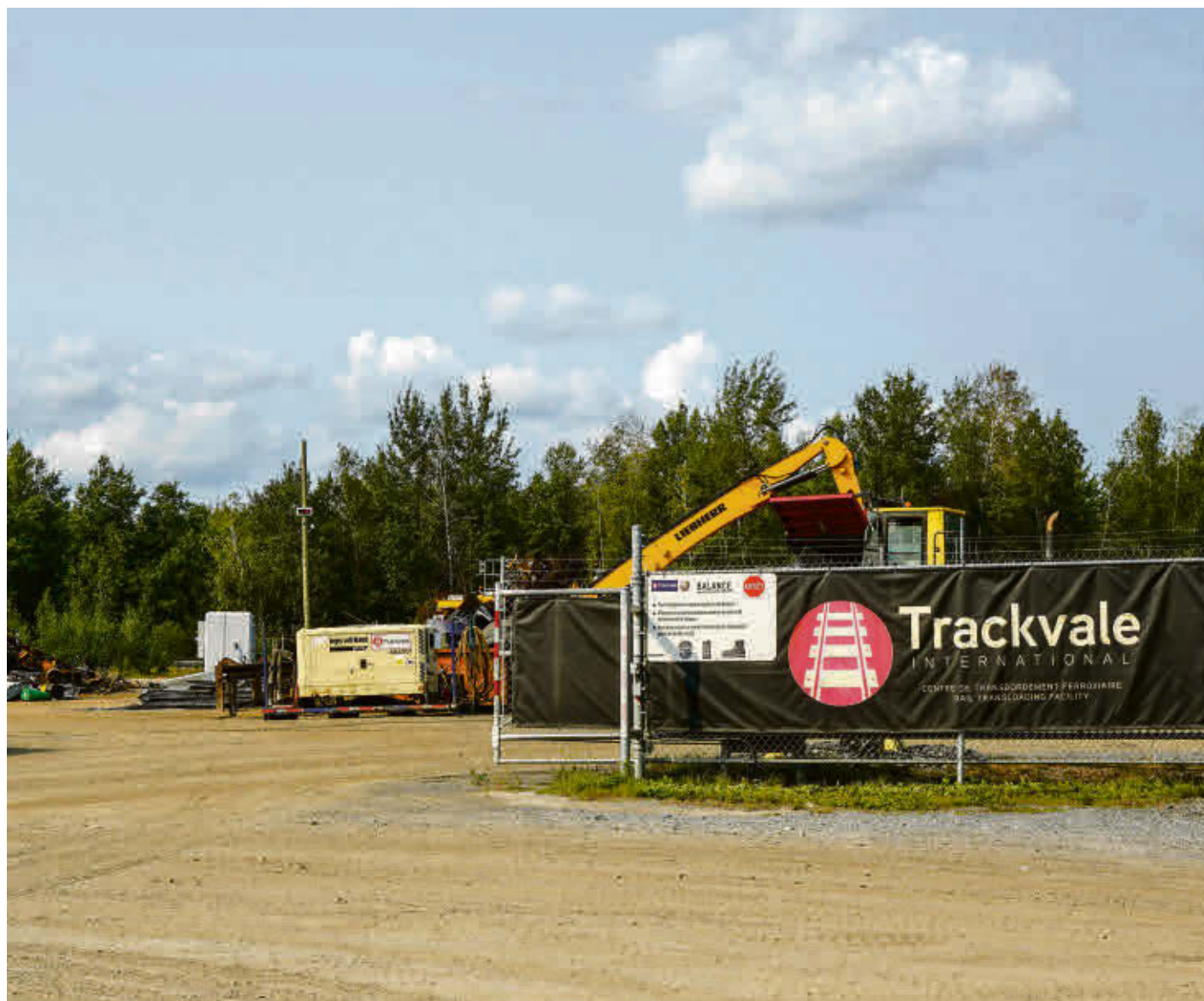
Trackvale est une entreprise valoise spécialisée dans le transbordement ferroviaire. Photo François Larivière | La Pensée ©
