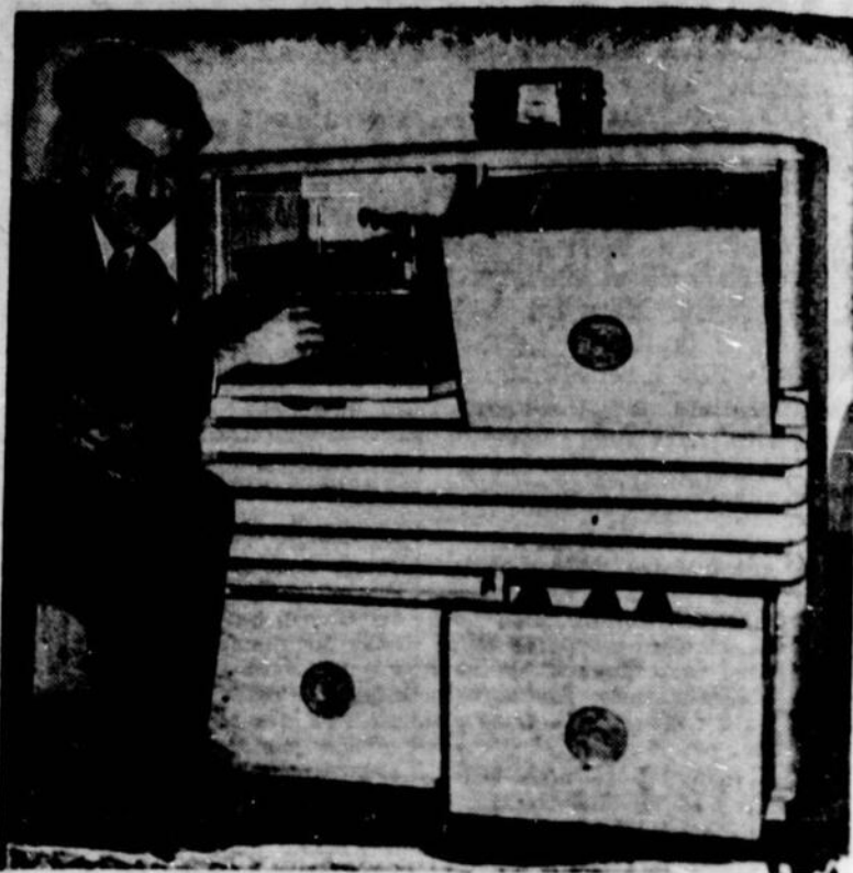
Voici l'appareil radiophonique que vient de réaliser un musicien bien connu à Montréal, M. Fernand Gaudrault, 5014, rue Marquette. Dans ses moments libres, M. Gaudrault a fabriqué ce cabinet avec du chêne; il y a combiné un appareil radiophonique et un phonographe automatique qui sont mobiles, les disques de phonographe sortent aussi de leurs casiers de façon automatique. Ce cabinet est un bijou de construction. — (Photo du "Petit Journal".)
