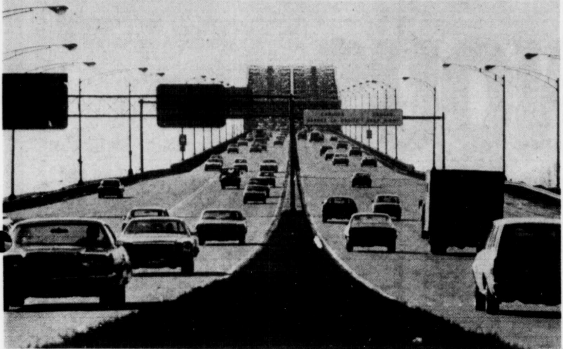
Il sera impossible de procéder à l'aménagement des voies réservées aux autobus sur le pont Champlain, avant que les travaux de réfection du pavé ne soient terminés.
