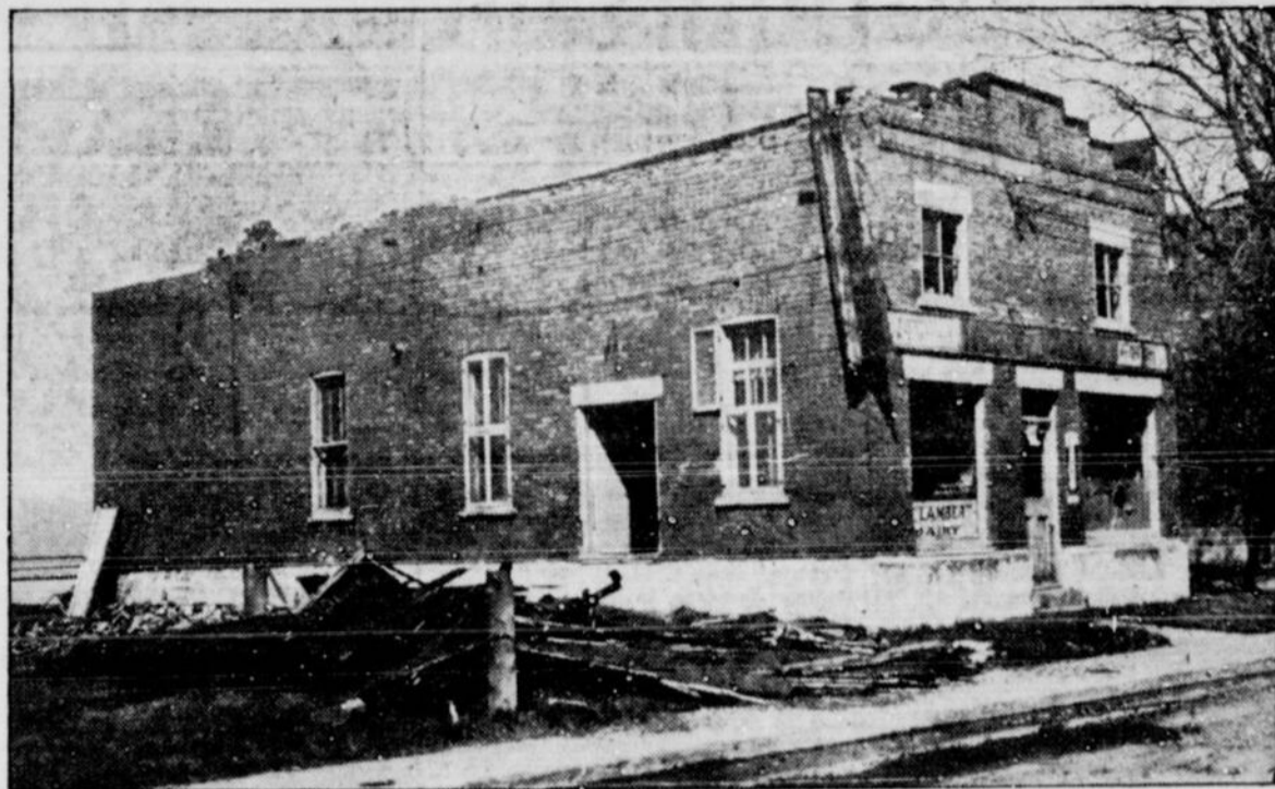
Dégâts de la tempête à Saint-Lambert. (Photo la "Patrie").
