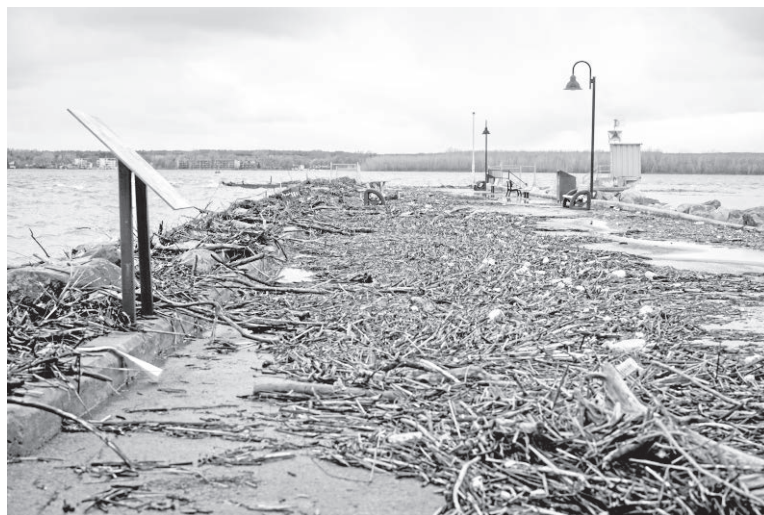
Le débordement du fleuve Saint-Laurent a amené son lot de débris sur ce quai à Nicolet. — PHOTO: FRANÇOIS GERVAIS
