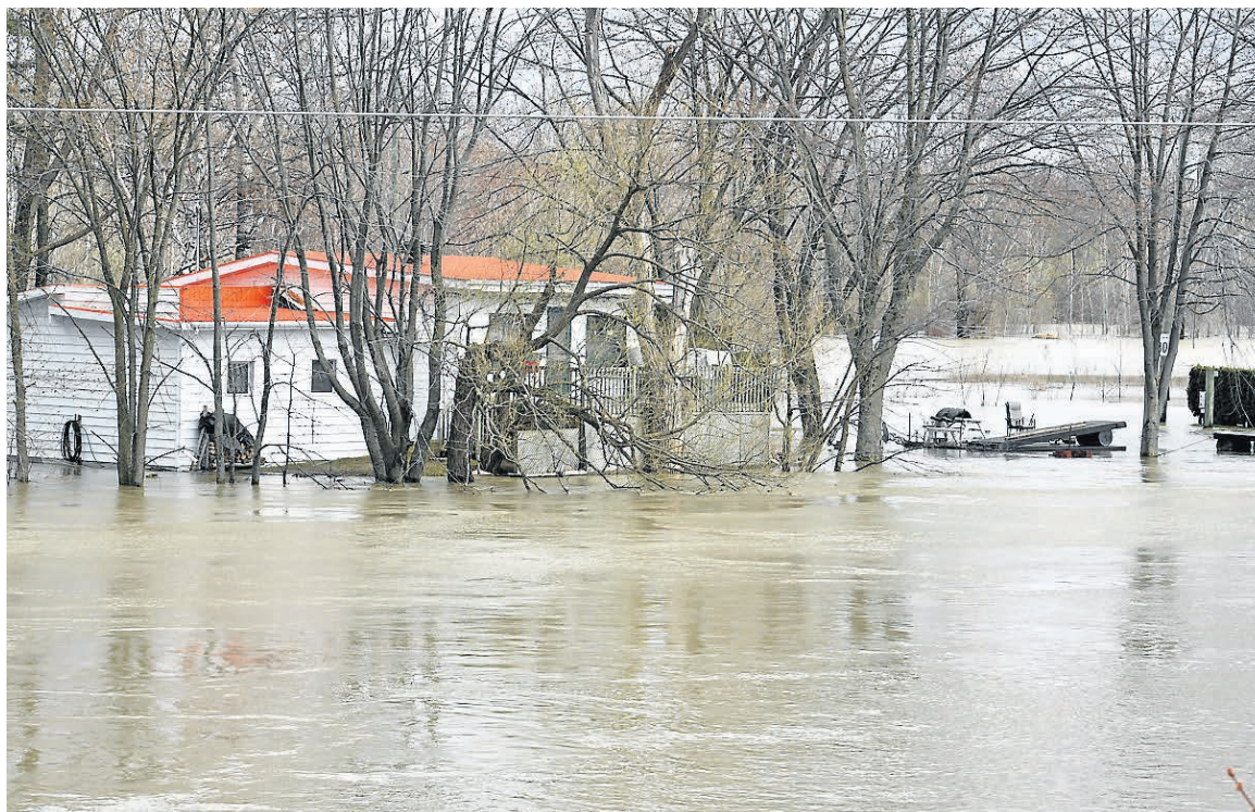
Les avenues Lac Saint-Pierre Est (photo) et Ouest, la portion sud de la rue Notre-Dame Sud et le secteur du rang de la Commune sont touchés par cette crue des eaux. L'inondation est complète dans le secteur du lac Saint-Pierre. Au total, entre 100 et 120 maisons sont victimes du haut niveau de la rivière du Loup, de la petite rivière du Loup et du lac Saint-Pierre. — PHOTO:STÉPHANE LESSARD
