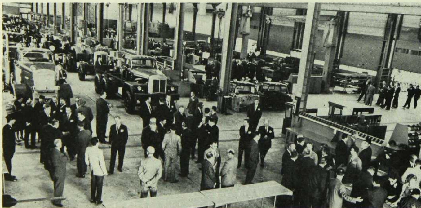
L'intérieur de l'usine le jour de l'inauguration
