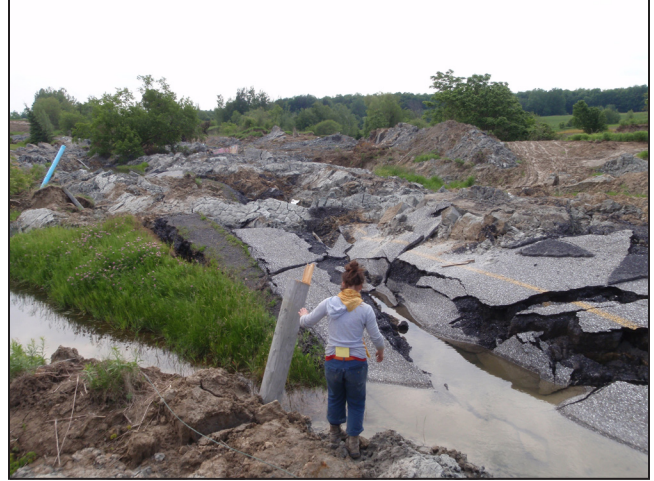
PHOTO 2 - Glissement de terrain de Saint-Jude dans une séquence de rythmites marines silto-argileuses.
