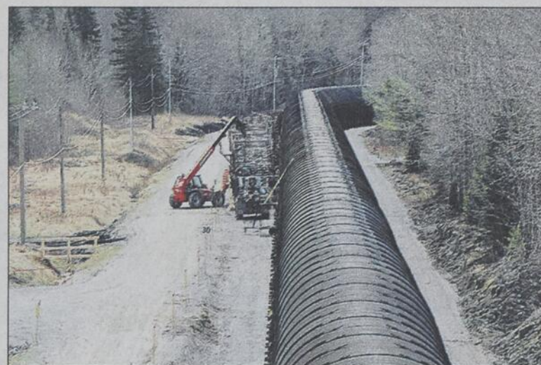
La construction de la conduite fut un véritable défi.
