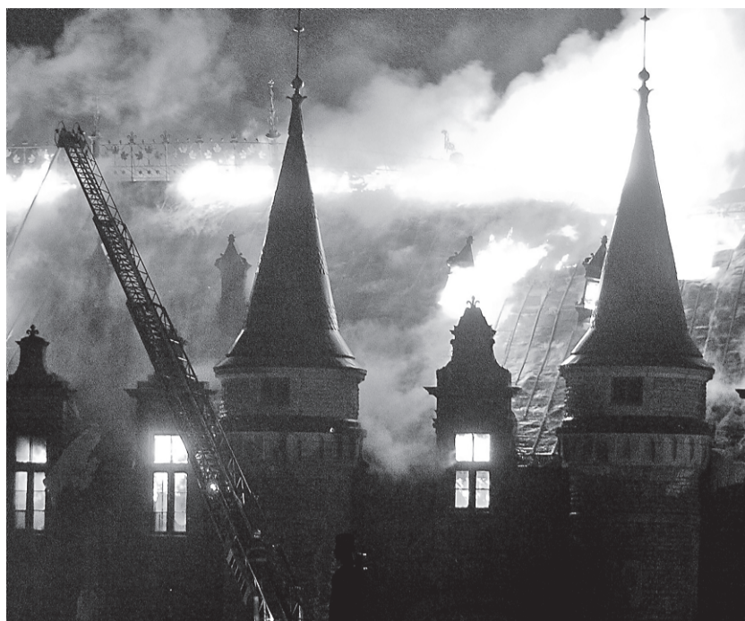
Le spectaculaire incendie du 4 avril a détruit tout le manège militaire, construit en 1885. Seule la façade a miraculeusement tenu debout.
