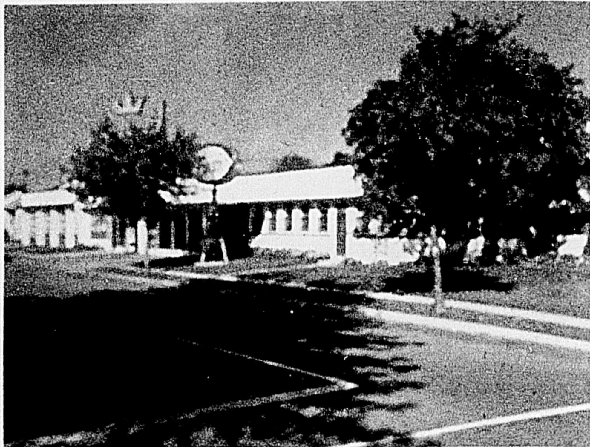
Vue d'ensemble de l'usine d'embouteillage.
