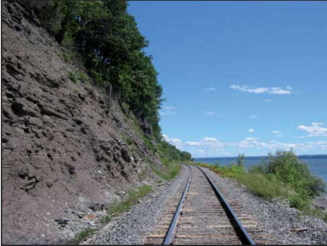
PHOTO 1 - Affleurement du Shale d'Utica, quai de Cap-Santé
