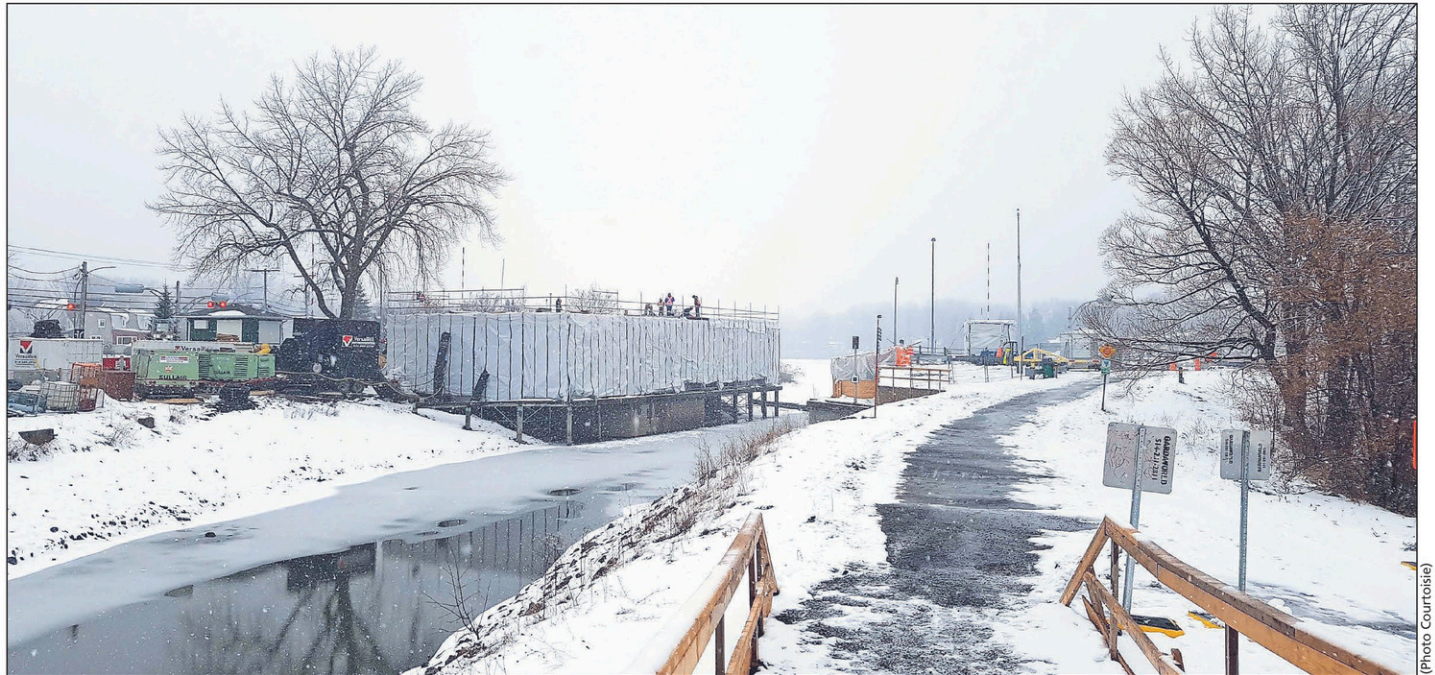
Les travaux au pont 10 se déroulent selon le calendrier prévu.
