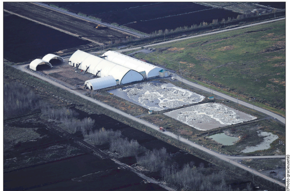
La technologie choisie s'inspire de l'usine de Moose Creek, en Ontario. La facture passera de 10 M$ à 22 M$.
