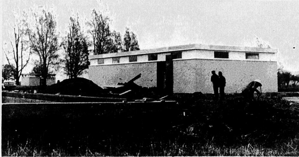
Au terrain de camping de Montmagny, selon le contracteur général, les travaux progressent normalement. Il n'en demeure pas moins que beaucoup resta à faire encore. Ici, on est à compléter l'aménagement et la réfection de la piscine existente.
