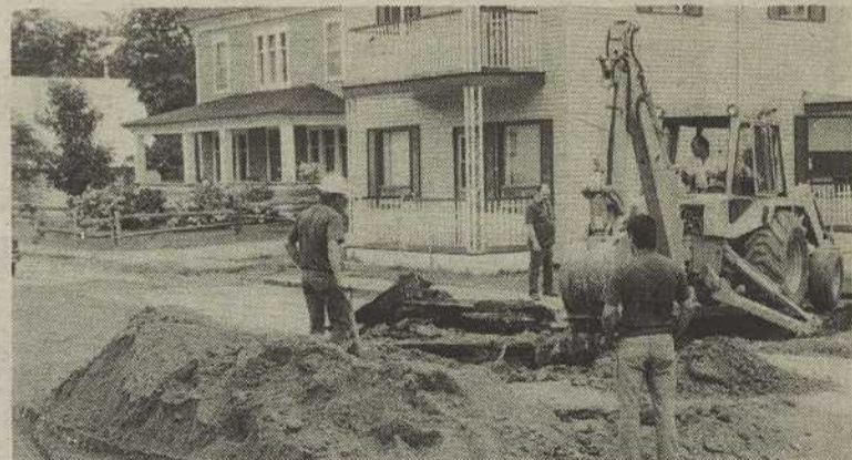
Selon le maire de Warden, les travaux devraient être terminés d'ici deux semaines.
