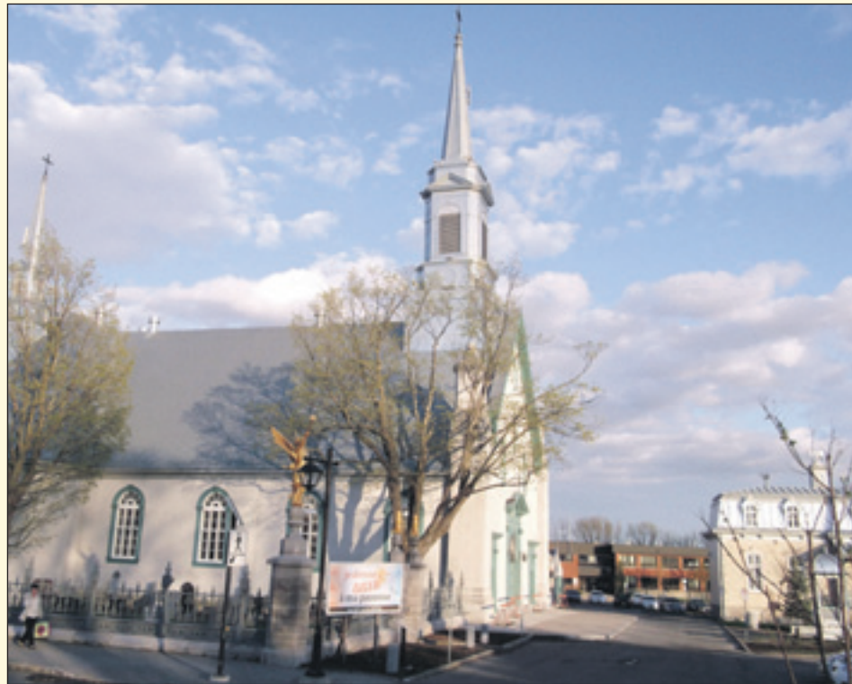
Des travaux majeurs, dont la réfection du plancher et la peinture intérieure de votre église, sont à prévoir.
