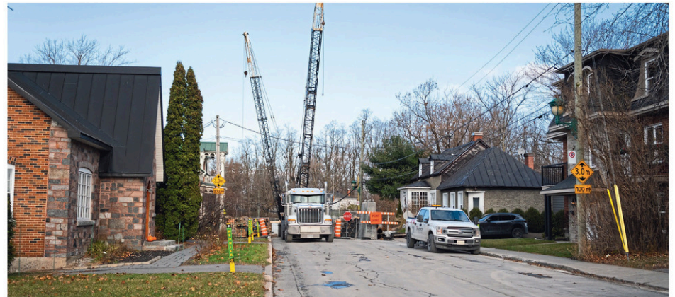
Le chantier au-dessus du ruisseau Hazen devait prendre fin en décembre. Il se terminera plutôt en février 2024. (Photo Le Canada Français - Laurianne Gervais-Courchesne)
