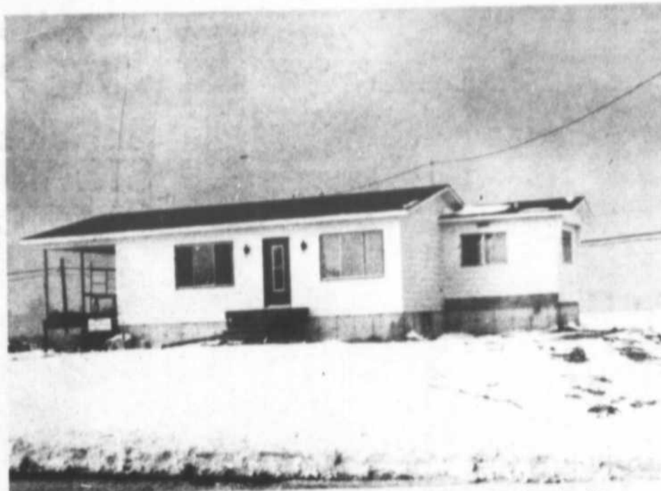
L'extérieur des bureaux situés au 15590 boul. Bécancour, Ste-Angèle.
