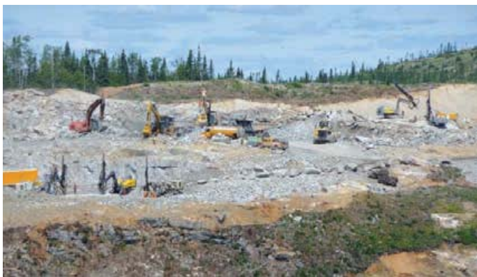
Engins de chantier au site de la centrale de la Romaine-1
