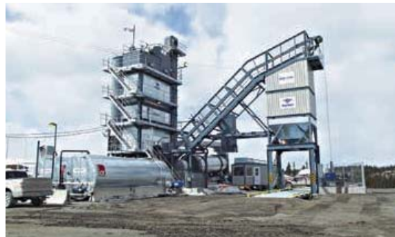
Usine de bétonnage à la Romaine-2
