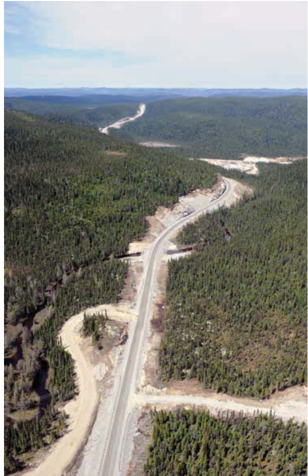
Route de la Romaine dans le secteur de la Romaine-3
