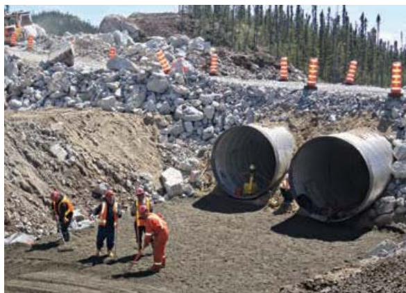
Mise en place de ponceaux au kilomètre 104 de la route de la Romaine
