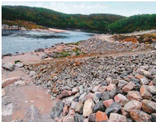
Rampe d'accès pour les canotiers à la Romaine-1
