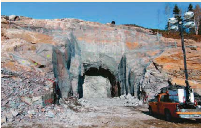
Entrée de la galerie d'accès aux conduites forcées
