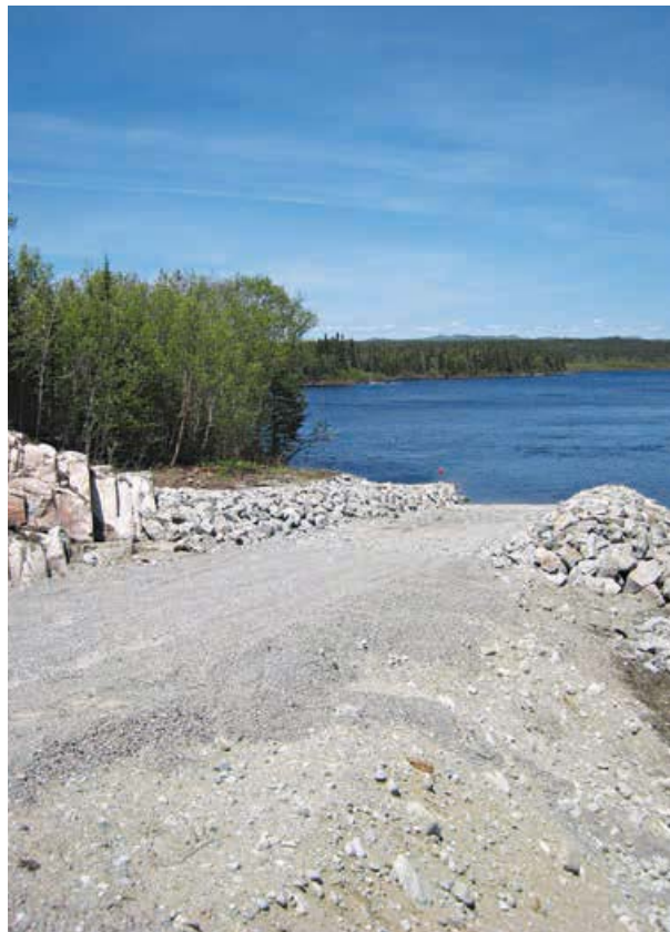
Rampe de mise à l'eau aménagée au PK 2 de la Romaine
