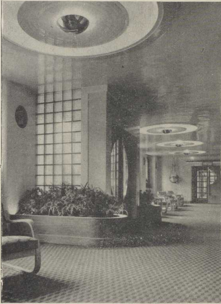
HEUREUSE UTILISATION DE LA BRIQUE DE VERRE DANS LE HALL D'ENTREE D'UN RESTAURANT DE LONDRES.
