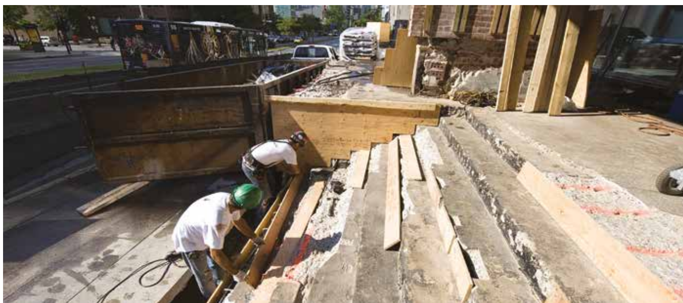
Réfection du parvis devant le siège social (2009).
