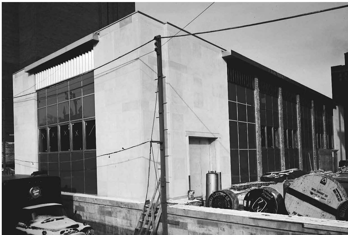
Bâtiment de commande du poste Dorchester en construction (vers 1960).
