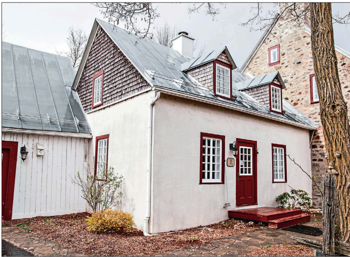
Son frontispice faisant face à la rivière, la cuisine d'été du complexe agricole Gagnon-Bourget est recouverte de crépi, un enduit non lissé fait de sable et de chaux qui sert à la protéger des intempéries.
