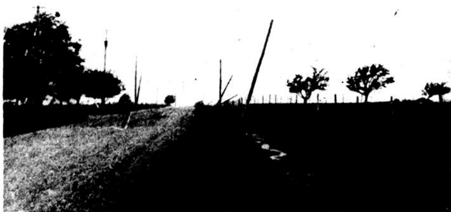
Dans un rang reliant Sainte-Élisabeth et Kingsey-Falls, de nombreux poteaux de la compagnie de téléphone de Warwick ont été balayés par les vents.
