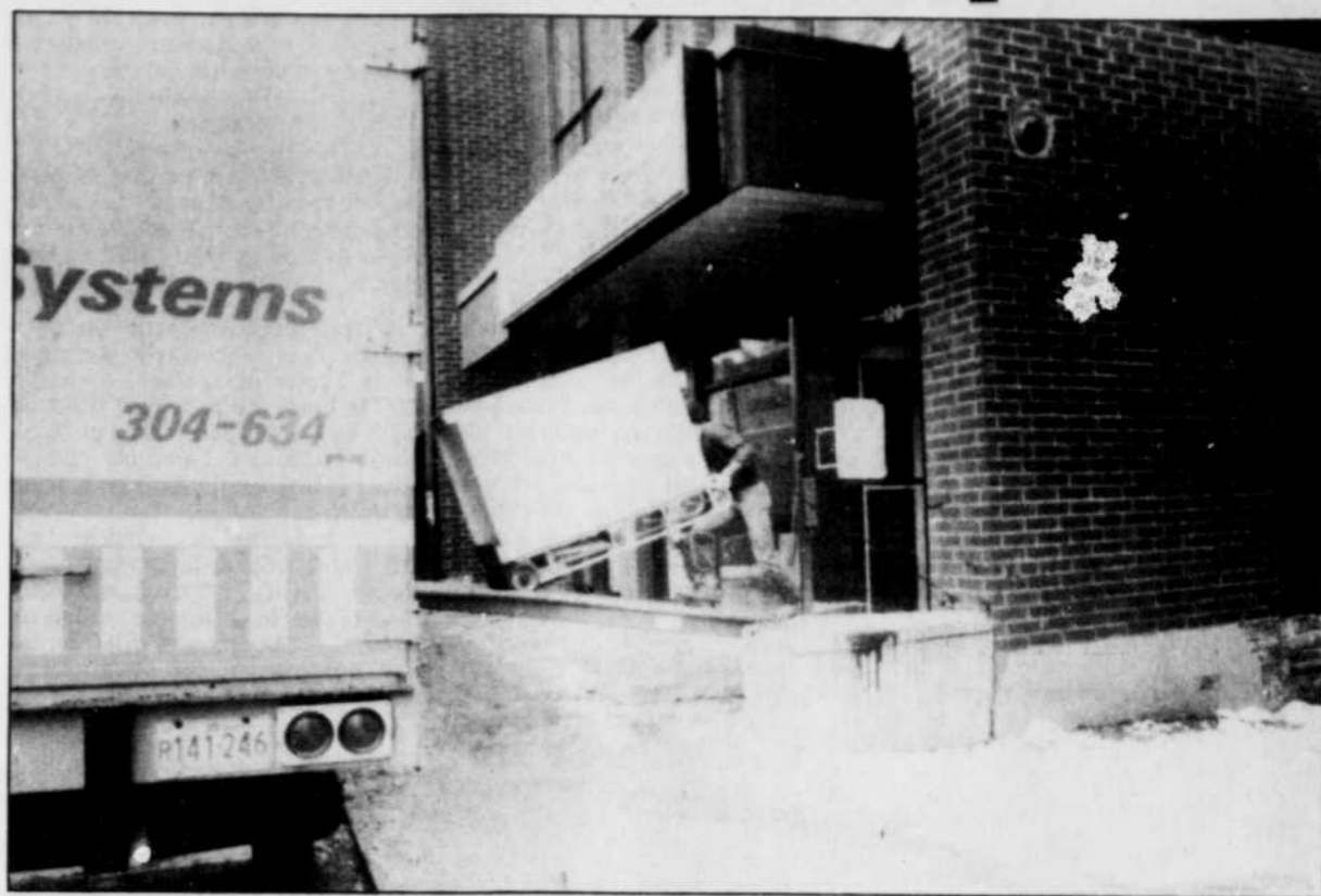
Parce qu'il présente un risque potentiel pour la sécurité des gens, l'édifice du 120 Wellington Sud, propriété de M. Saad Gabr, par l'entremise d'Hatley Acres, a été évacué par ses locataires.
