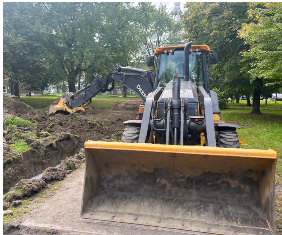
Des travaux d'excavation ont eu lieu en octobre dernier. (Photos : archives)
