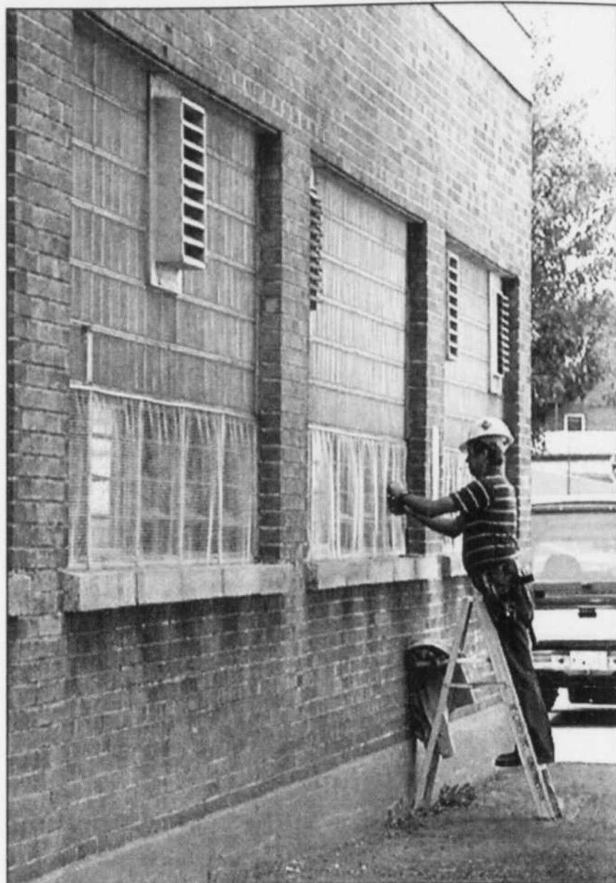
(Image-Média Mauricie: Patrick Beauchamp) Des moustiquaires et des grillages ont été installés au pavillon Saint-Joseph du Centre hospitalier régional de Trois-Rivières afin d'éviter une nouvelle infiltration de chauves-souris.
