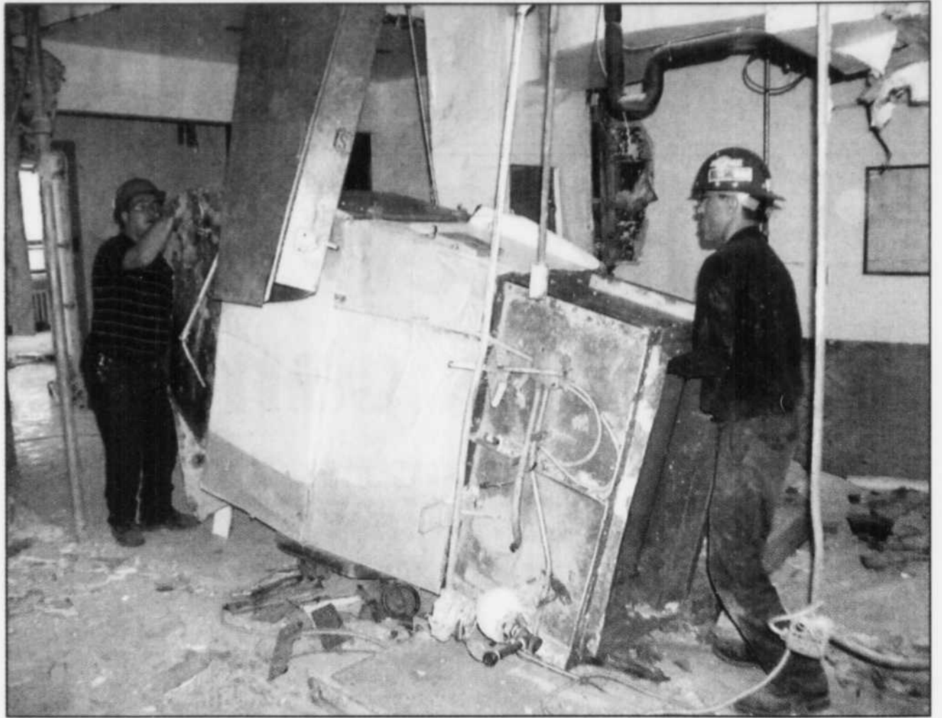
Deux ouvriers s'affairent à déménager un lourd appareil dans le cadre des travaux d'agrandissement et de rénovation qui ont repris, en début de semaine, au Complexe santé et services sociaux Nicolet-Yamaska de Nicolet, au terme des vacances dans le domaine de la construction. Ces travaux se poursuivront jusqu'à la fin de l'année 2000.
