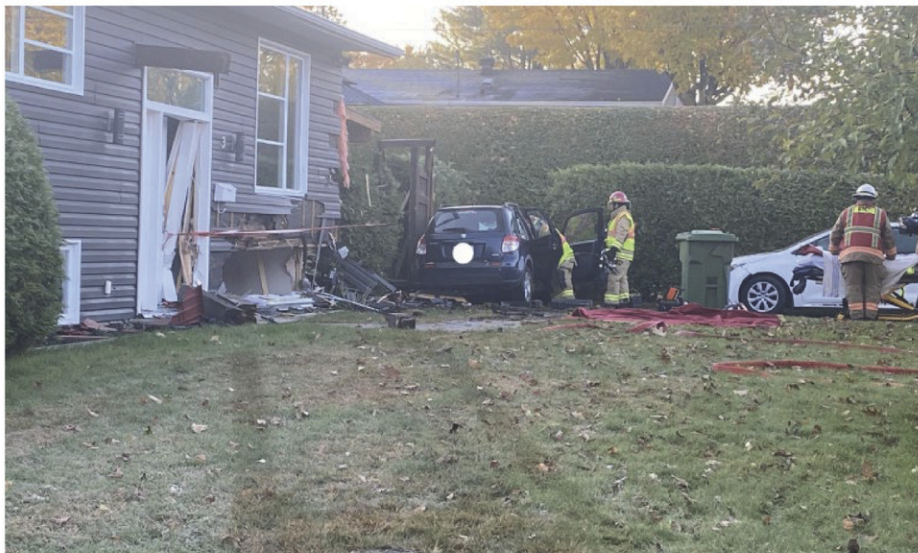
Des blessures mineures pour le conducteur, mais des dommages importants à la résidence. (Photo www.lanouvelle.net)
