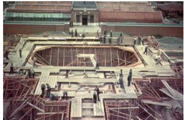
Construction des serres
