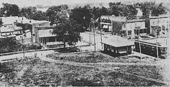
Photo de l'ancienne station des tramways électriques de la Montreal & Southern Counties Railway située au coin des rues St-Denis et Elm à St-Lambert.
