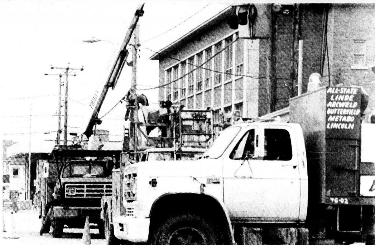
Dernière phase dans la construction de Place Centre-ville, le nouveau centre commercial sis entre l'avenue St-Jérôme et la rue Bon-Pasteur à Matane. L'ouverture est prévue pour bientôt et tous les services publics ont fait diligence pour terminer leurs travaux à temps. [Photo La Voix Gaspésienne]
