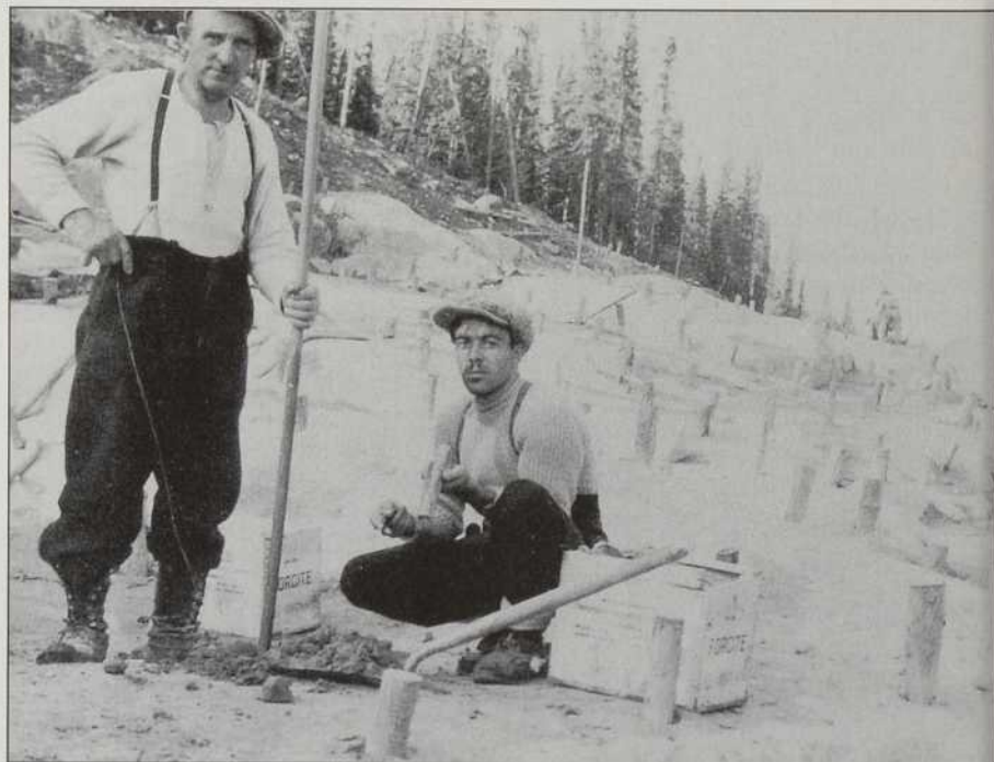
Des travailleurs préparant un dynamitage dans le parc des Laurentides. Environ 600 hommes ont participé à la construction de cette route, de l'hiver 1944-1945 jusqu'à l'été 1948.
