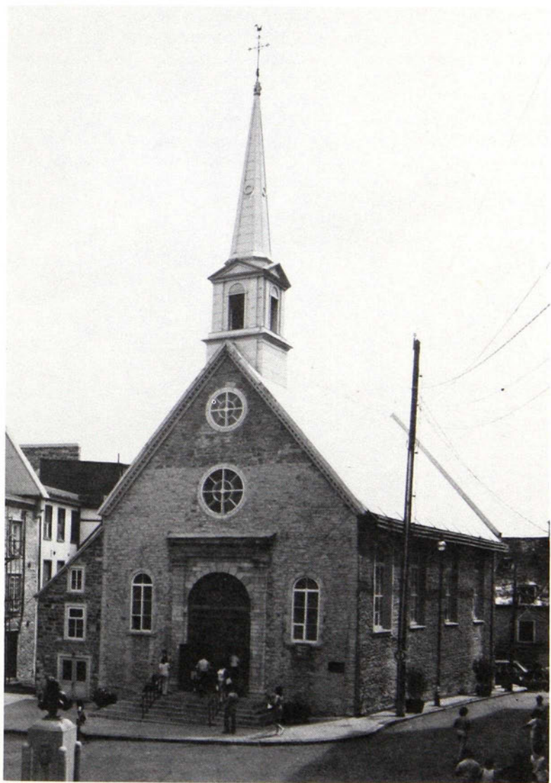
2. Vue de la façade actuelle.
