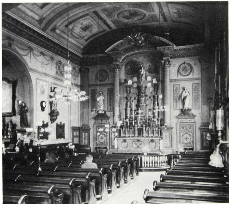
41. Vue de l'intérieur de Notre-Dame-des-Victoires après les travaux de 1888.
