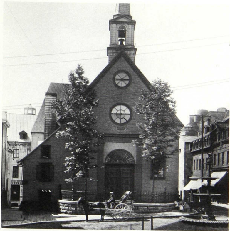
42. Vue de la façade vers 1880.
