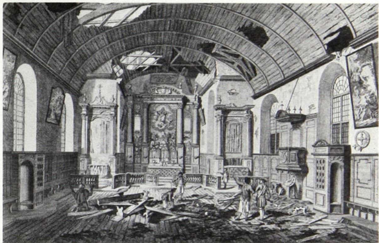
34. Vue de l'intérieur de l'église des Récollets de Québec, construite en 1693, après les bombardements de la ville en 1759. Dessin gravé de Richard Short.
