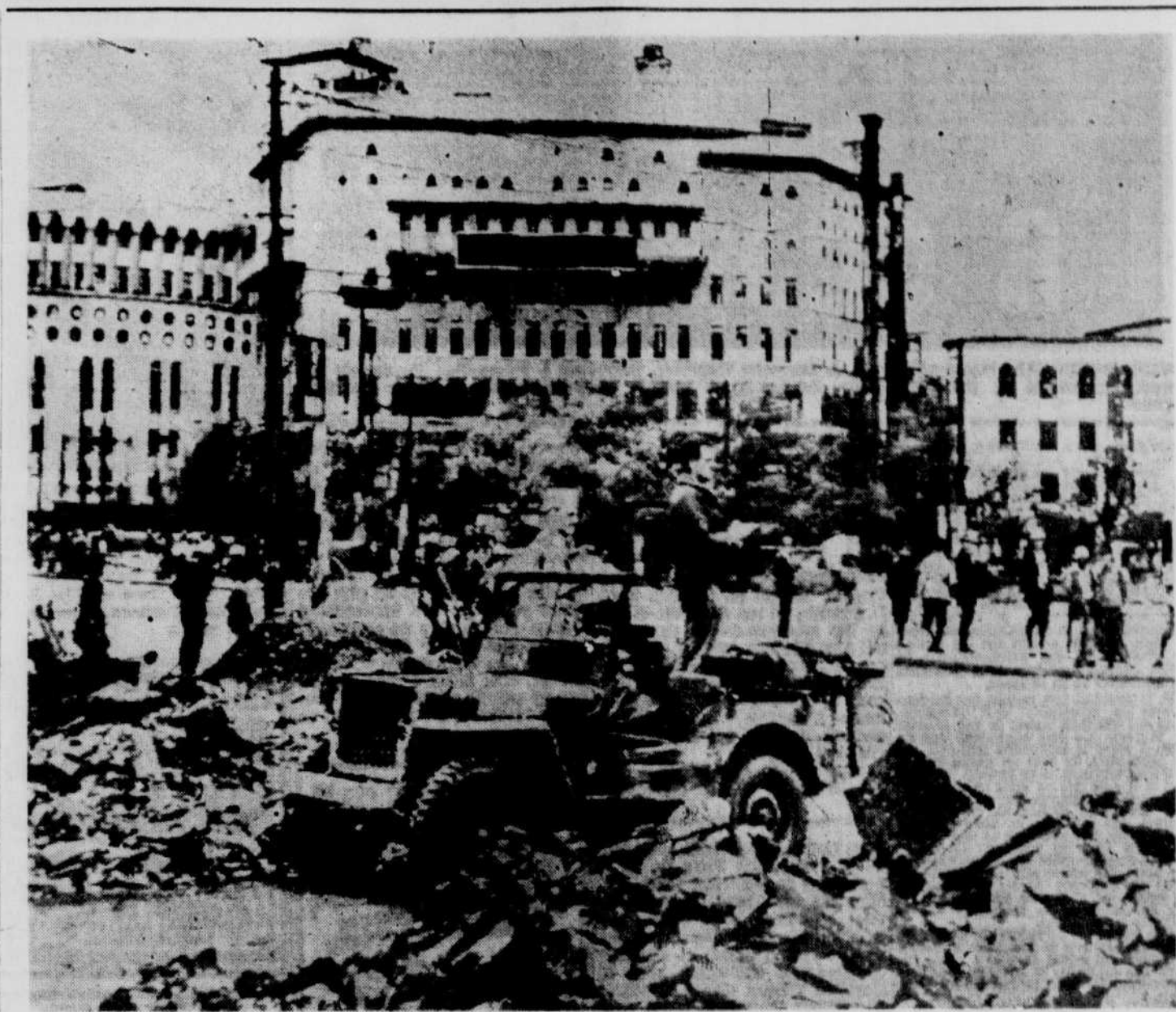
A TRAVERS TOKIO EN RUINES : Les premiers gardes-côtières à entrer dans Tokio montent sur leur jeep pour examiner les dommages causés par les bombes alliées à l'une des principales sections de la capitale japonaise. Deux gros édifices modernes appartenant à l'arrière-plan semblent n'avoir subi aucun dommage. Les Américains sont, de gauche à droite, HARVEY-L. TWYMAN, de Omaha, Neb., HARMON LAUGHER, de Berkeley, Cal., et JOHN PAPSUN, de Birmingham, Mich. (International News)
