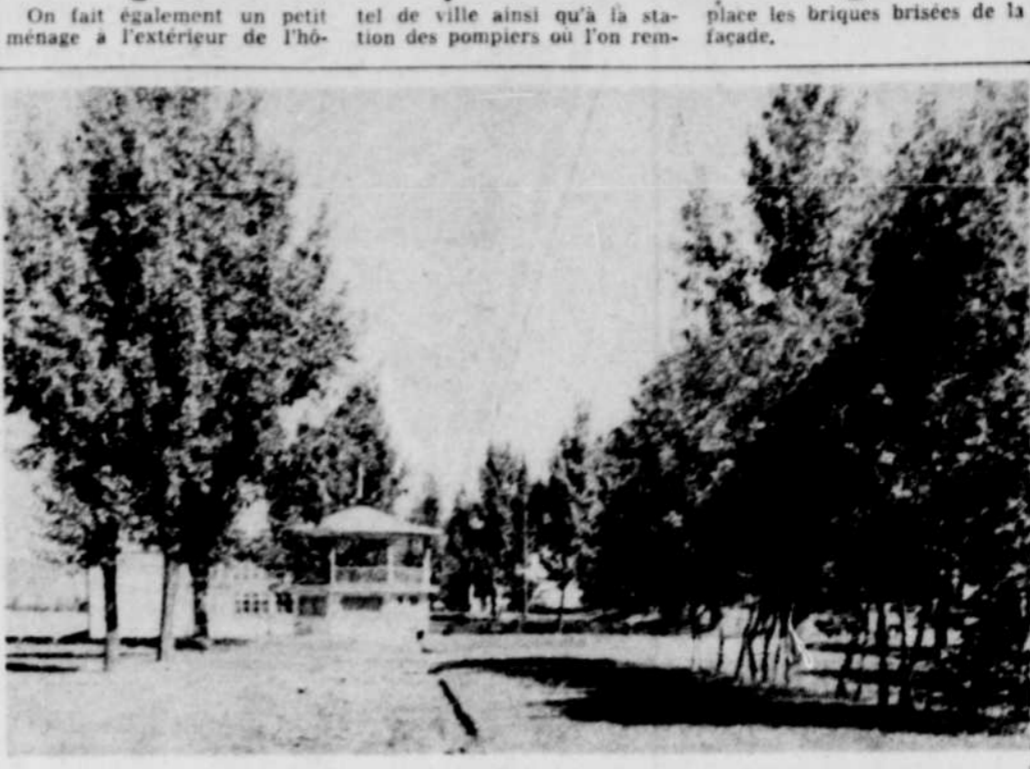
(Photo Le Nouvelliste) DE LA TOURBE a été installée et des allées ont été tracées sur le côté ouest du parc St-Eugène. Les employés municipaux parachevaient leur travail hier matin.
