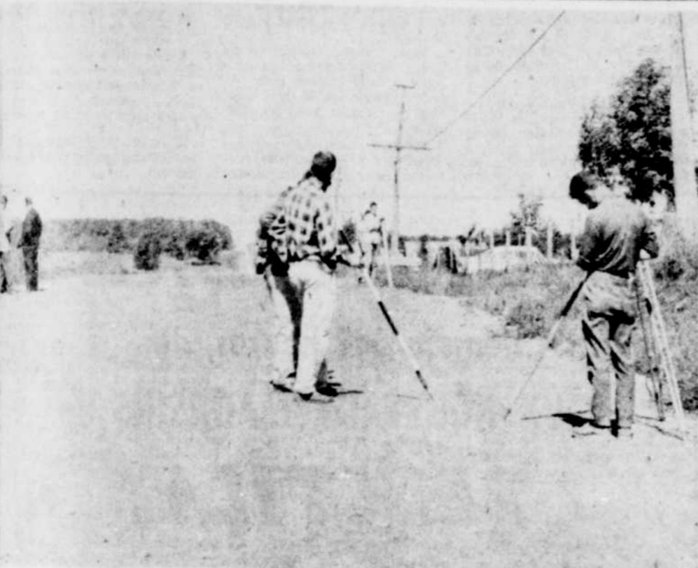
LES ARPEUTEURS préparent le tracé pour les travaux d'élargissement du boulevard St-Jean. C'est de dire que d'ici peu le contrat sera accordé et les automobilistes pourront circuler sur une route qui aura 16 pieds de plus que la largeur actuelle qui est de 50 pieds.
