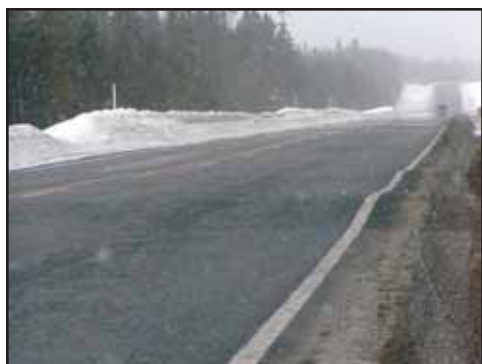
Figure 1 : Soulèvement causé par le gel
