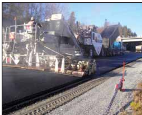
Figure 2 – Utilisation d'un véhicule de transfert de matériaux (VTM) pour homogénéiser la température
