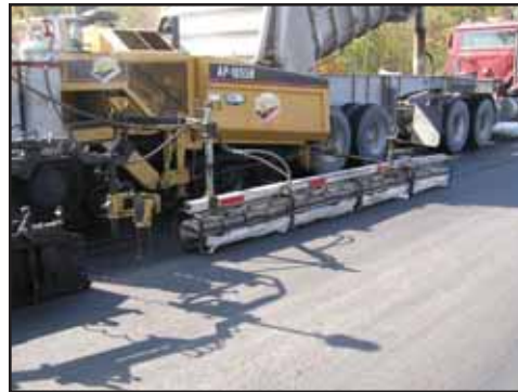
Figure 4 – Utilisation d'un chauffe-joint
