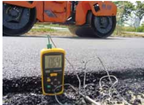
Photo 5. Mesure de la température pendant le compactage // Temperature measurement during the compaction stage.
