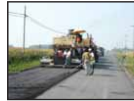
Figure 7 - Route 235 - Recyclage en cours
