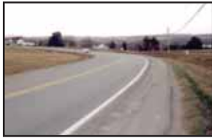
Figure 4 - Recyclage en place-resurfacement 1992 - Route 143, Bromptonville 1999 (7ans)
