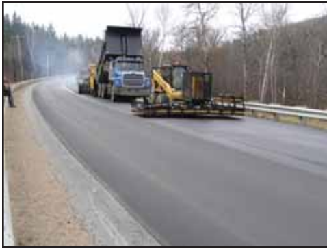
Figure 3 – Utilisation d'un chauffe-surface à infrarouge pour réchauffer la surface à recouvrir
