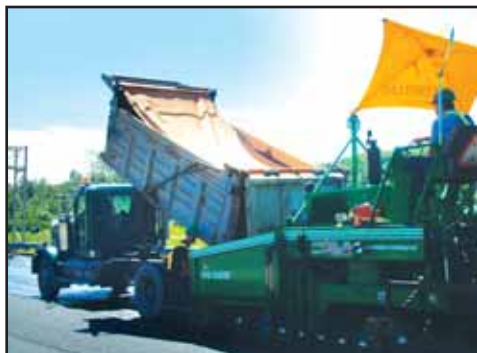
Figure 1 – Maintien de la bâche pendant le déchargement
