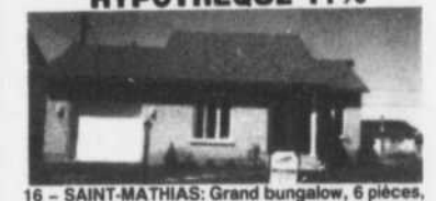
16 - SAINT-MATHIAS: Grand bungalow, 6 pièces, garage, construction neuve & garantie APCHQ, occupation immédiate. ROBERT LANDRY: 464-4441.
