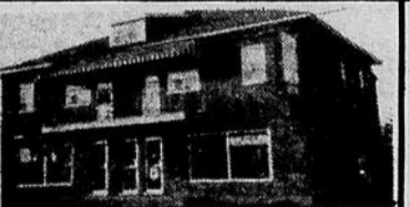
Centre-ville , 6 revenus plus 2 locaux commerciaux, rénovation récente. Georges Gendreau, 724-6130. 722-7695.
