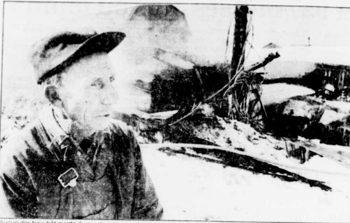
Aucun des trois bâtiments du moulin à bois de Georges Lessard n'est assuré contre le feu.
