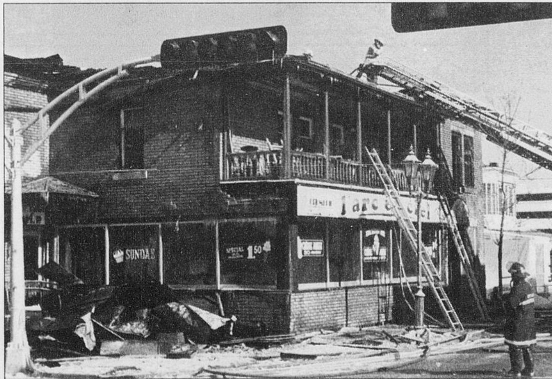
PERTE TOTALE - La bâtisse abritant le bar «Le triple sexe» de Jonquière est une perte totale. Les enquêteurs n'écartent aucune hypothèse quant aux causes de cet incendie.
