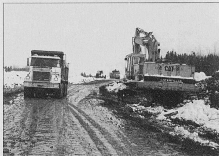
TRAVAUX - La décision de La Baie d'annuler l'octroi du contrat à l'entreprise Fernand Gilbert a pour effet d'interrompre les travaux au ruisseau Benjamin.
