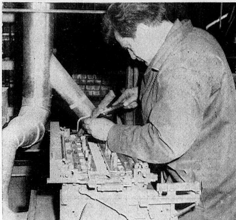
L'étape que l'on peut voir ici consiste en un soudage des plaques ensemble. Elles sont toutefois séparées par une plaque isolatrice afin de ne pas se toucher les unes les autres.
