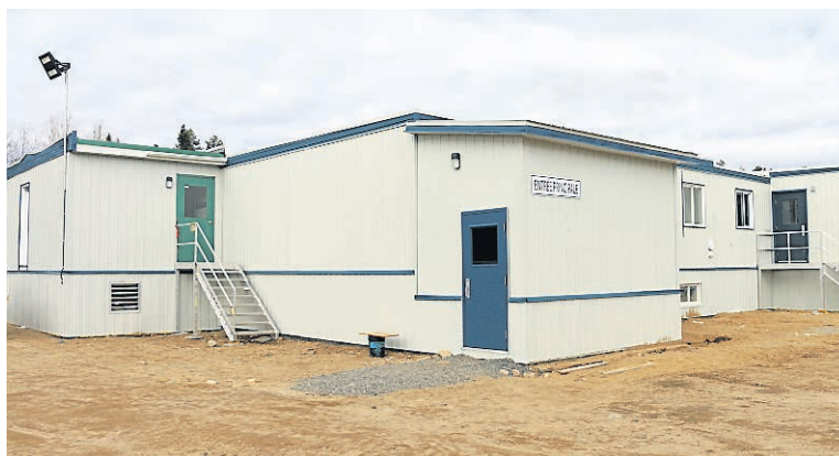
Le complexe d'hébergement pour les travailleurs comprend aux alentours de 140 chambres.—PHOTO: AUDREY TREMBLAY
