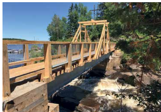
Walkway at chute à Ménard in Saint-Michel-des-Saints
