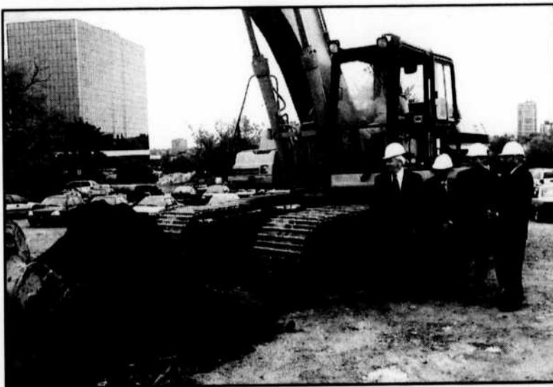
Les députés Réjean Lafrenière, Roch Cholette, Benoît Pelletier et Marcel Proulx ont assisté à la première pelletée de terre du nouveau tronçon de McConnell-Laramée.
