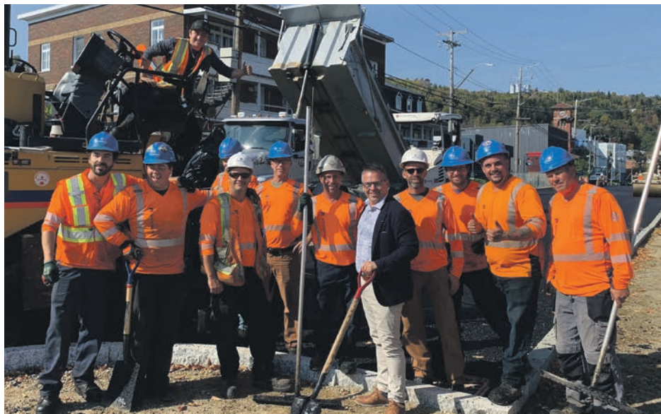
Le maire de La Malbaie et des travailleurs sur le chantier de la rue Saint-Étienne. Photo archives
