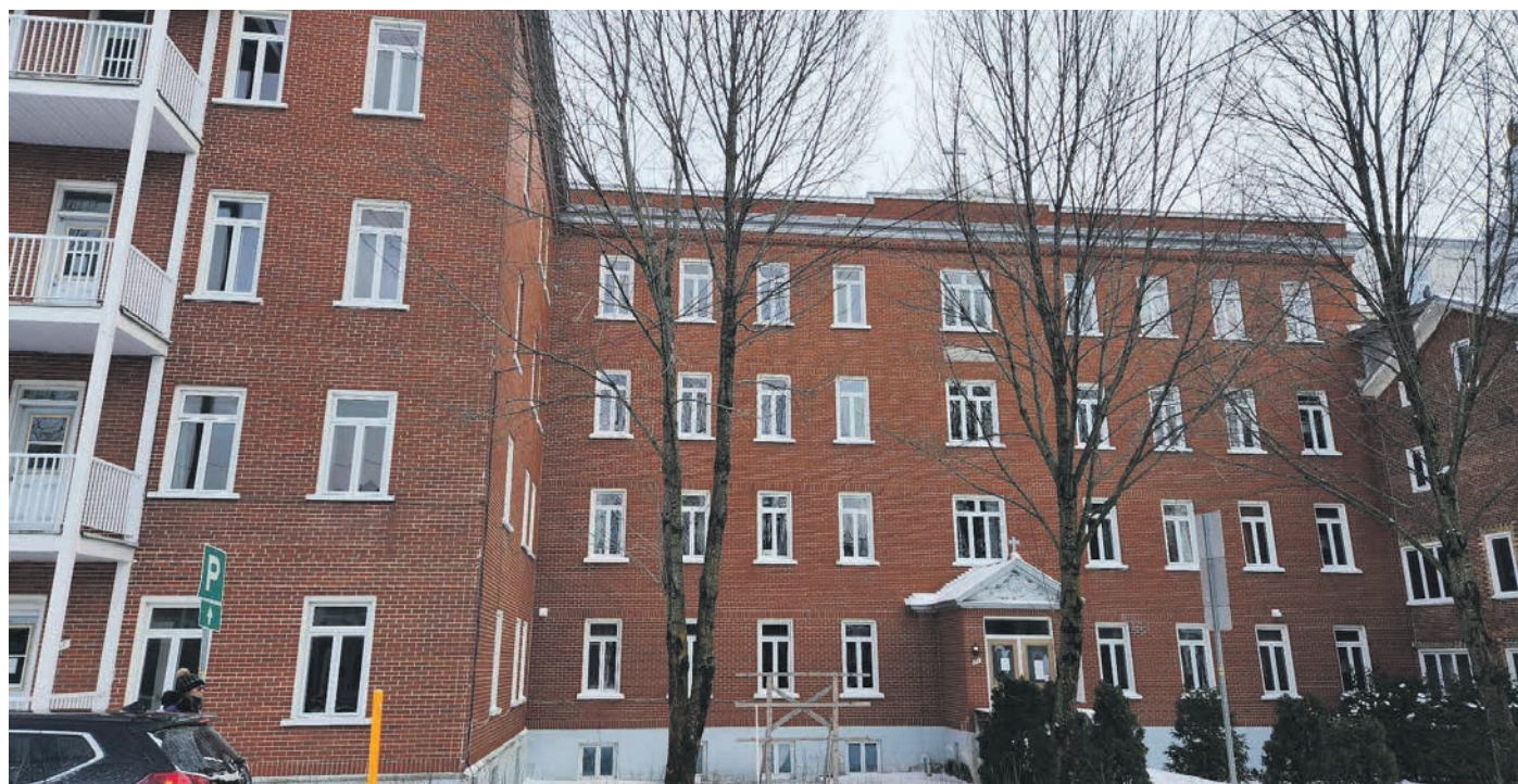
Le bloc 6 de Maison Mère, qui doit accueillir le futur Espace bleu de Baie-Saint-Paul. Photo Lisianne Tremblay
