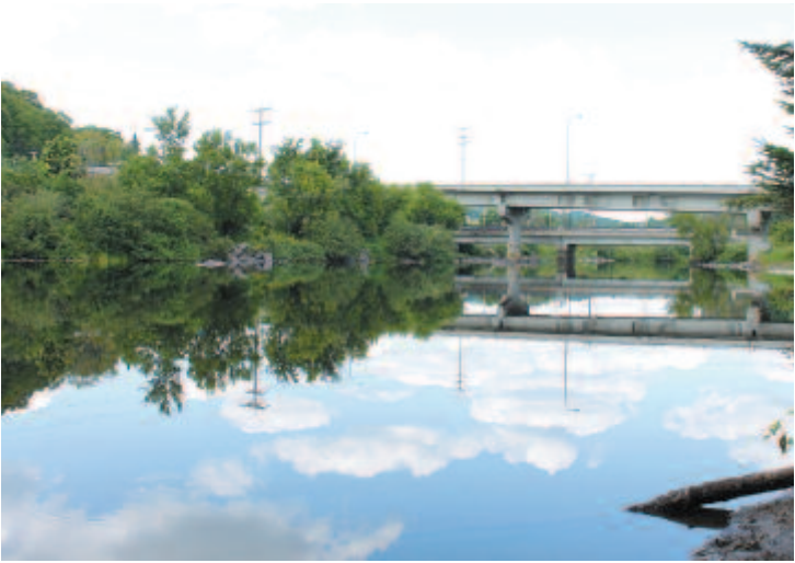
Le pont qui mène à Mont-Rolland. Un endroit paisible, mais impressionnant durant les crues printanières. Une embarcation ne peut passer sous le petit pont avec ses passagers.
